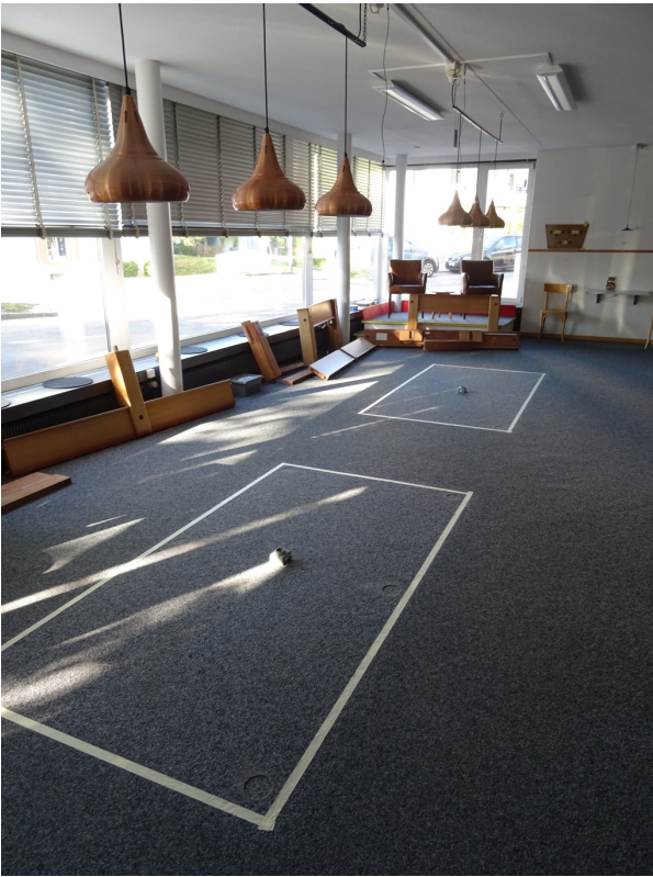
sauber demontiert und genaue Position markiert
